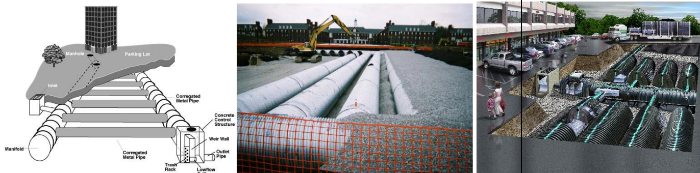
Figura 24 – Esempio di strutture di laminazione costituite da tubazioni sotterranee e sovradimensionamento del sistema di drenaggio delle superfici impermeabili
