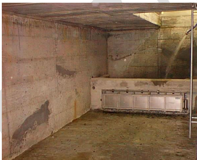
Figura 22 – Esempi di applicazione di vasche di laminazione sotterranee per piccole e medie estensioni, strutturabili sia per la sola laminazione con scarico in sistema di infiltrazione, sia per il riuso (tratte dal sito http://www.3pttechnik.it/it/home.html )
