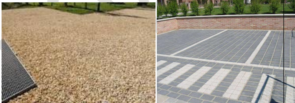
Figura 33 – Esempi di pavimentazione porosa
