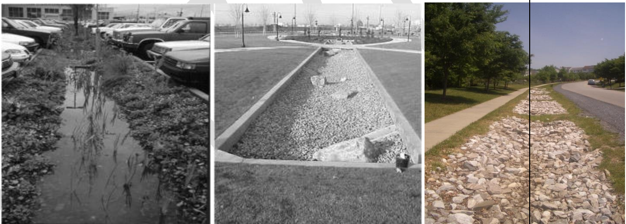
Figura 28 – Esempi di trincee d’infiltrazione
